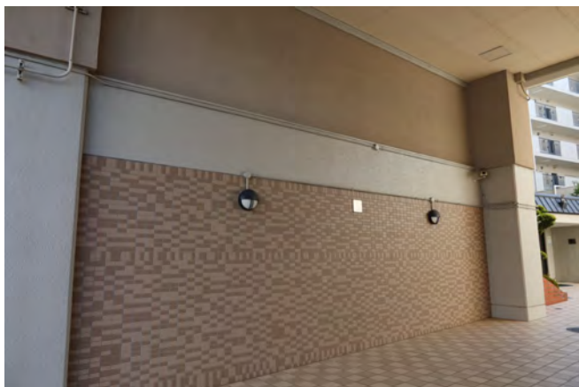
耐震補強されたピロティ壁
