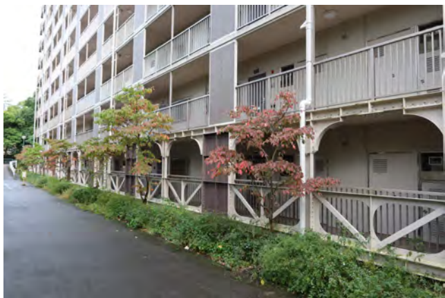
耐震補強された1階共用廊下
